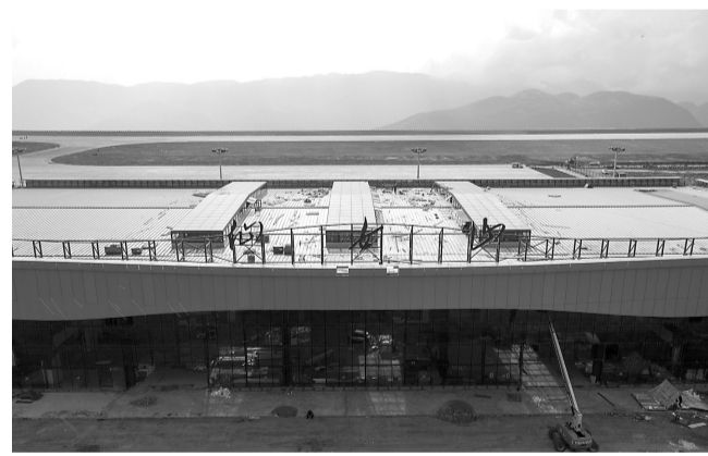
7月31日拍摄的正在进行外立面装修的重庆仙女山机场航站楼,重庆仙女山机场建设整体进入收尾阶段,预计8月中旬开展校飞等工作,计划于2020年建成并取得机场使用许可证。
