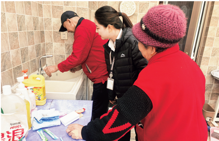
萨尔斯堡小区物业工作人员入户为居民维修水龙头。
