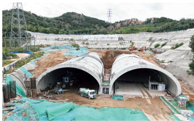
青岛市李沧区建设中的唐山路隧道。9月22日,青银高速公路增设唐山路互通及连接线工程唐山路隧道主体正式完工,全面进入隧道路面与装饰施工阶段。据介绍,该隧道是我国目前最大跨度断面市政交通隧道。 新华社发
