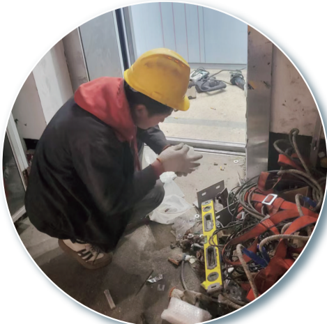
新家园小区的电梯正在更换中。
