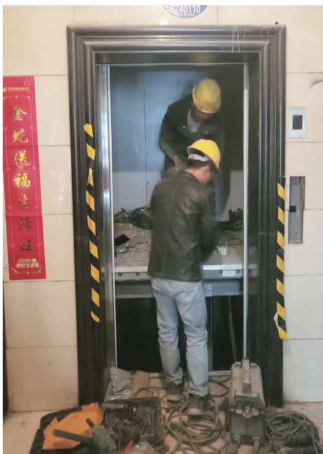
恒通家园小区的电梯正在更换中。
