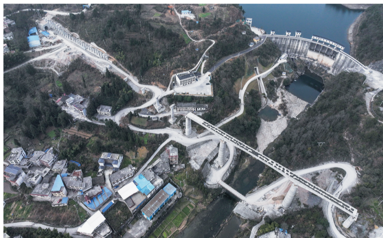
这是1月16日拍摄的贵州瓮马铁路南延伸线谷江河大桥施工现场。当日,由中铁二十局承建的五七连隧道顺利贯通,标志着贵州瓮马铁路南延伸线隧道全部贯通,为后续铺轨架梁工作奠定基础。瓮马铁路南北延伸线北起瓮安延伸至遵义,南起马场坪延伸至都匀,全长148公里。
