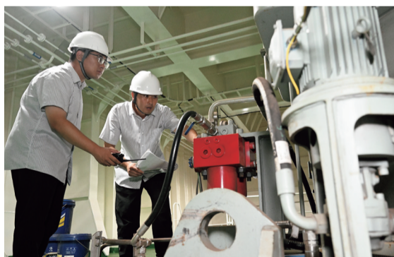
8月15日,国内首艘搭载智能船舶系统的自升自航式海上风电安装平台“港航平5”轮出海试航,预计将于本月底正式交付。正式投用后预计一年可安装海上风机100台。
