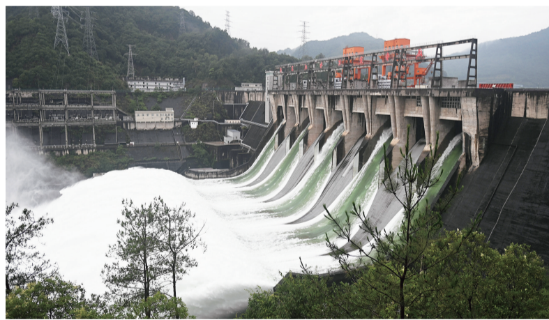
6月24日拍摄的开启5孔泄洪的新安江水库。当日,浙江省水利厅发布3号调度令,从15时30分起,位于浙江建德的新安江水库开5孔泄洪闸泄洪,同时新安江水力发电厂维持所有机组满负荷发电。新华社发
