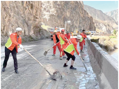
共和公路段干部职工齐上阵。 本组图片由青海省交通运输厅提供
