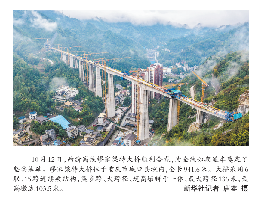
10月12日，西渝高铁缪家梁特大桥顺利合龙，为全线如期通车奠定了坚实基础。缪家梁特大桥位于重庆市城口县境内，全长941.6米。大桥采用6联、15跨连续梁结构，集多跨、大跨径、超高墩群于一体，最大跨径136米，最高墩达103.5米。 新华社记者 唐奕 摄
