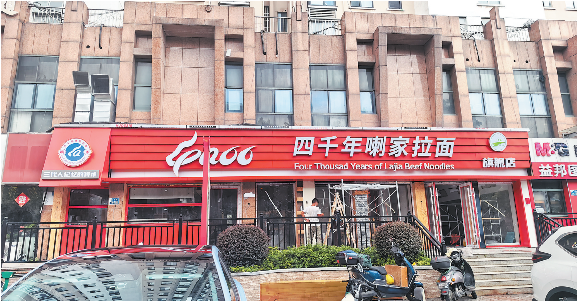
正在装修的拉面店。
