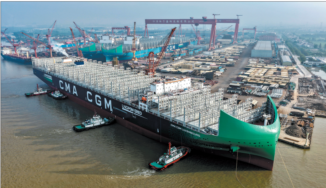
8月18日,超大型双燃料集装箱船“鑫福145”轮停靠江苏扬子鑫福造船舫装码头,开展离泊前各项准备工作(无人机照片)。 8月18日,由江苏扬子江船业集团建造的24000TEU级超大型双燃料集装箱船“鑫福145”轮,在海事部门全程护航下,从泰兴市江苏扬子鑫福造船舫装码头安全离泊。该轮总长399.9米、型宽61.3米、型深33.5米,是全球超大型绿色环保双燃料集装箱船。 新华社发 顾继红 摄
