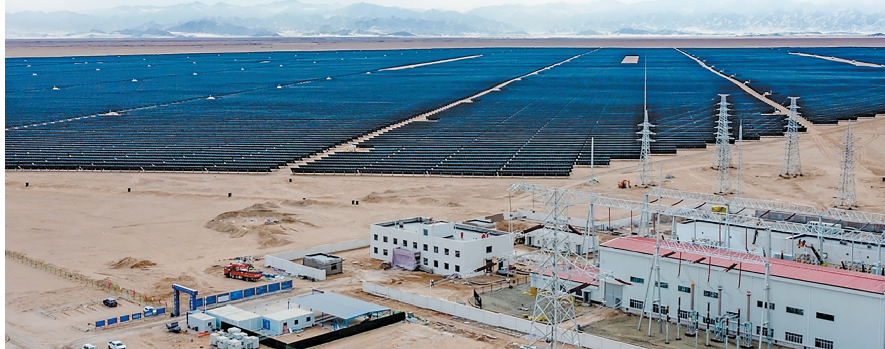
青海油田凯驰光伏电站光伏板整齐排列。
