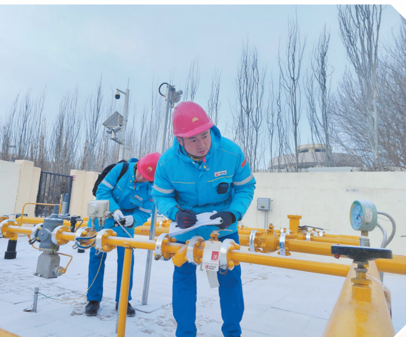
检查燃气管道。
