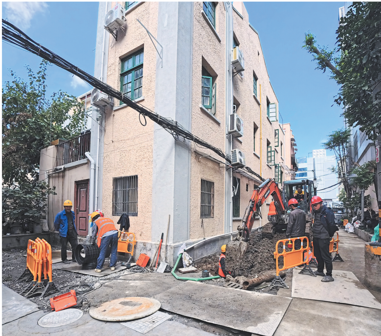
这是10月31日拍摄的愚园路1407弄小区污水管道更新施工现场。
