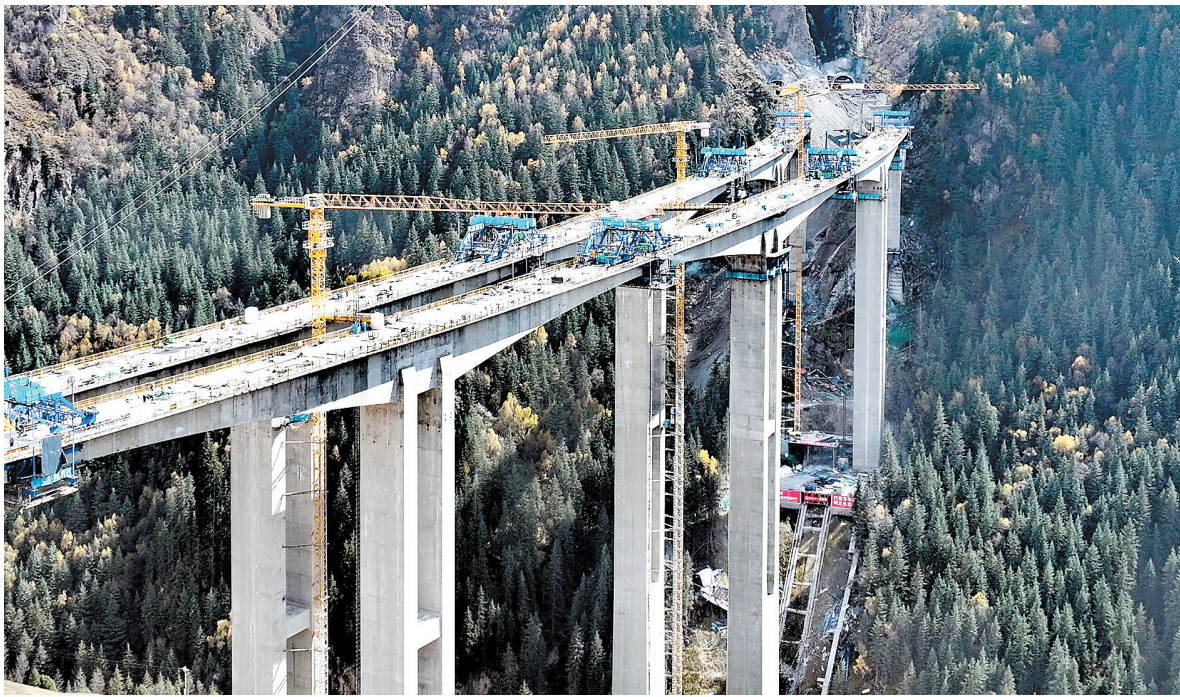
在建最高墩大桥顺利合龙。通讯员 鄯昌宇 唐业堡 摄
