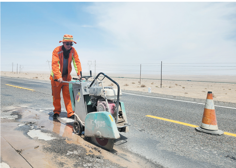
丁永维整修破损路面。
