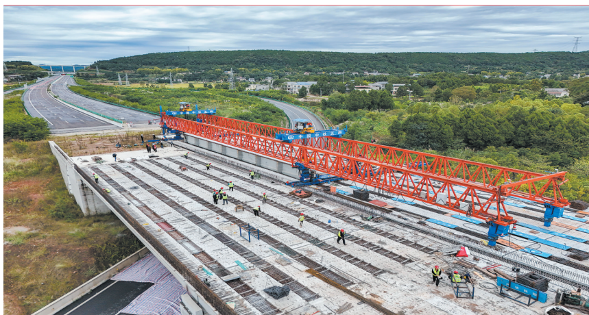
这是10月12日拍摄的京昆高速广元至绵阳段扩容工程牛头河大桥架梁作业现场(无人机照片)。
