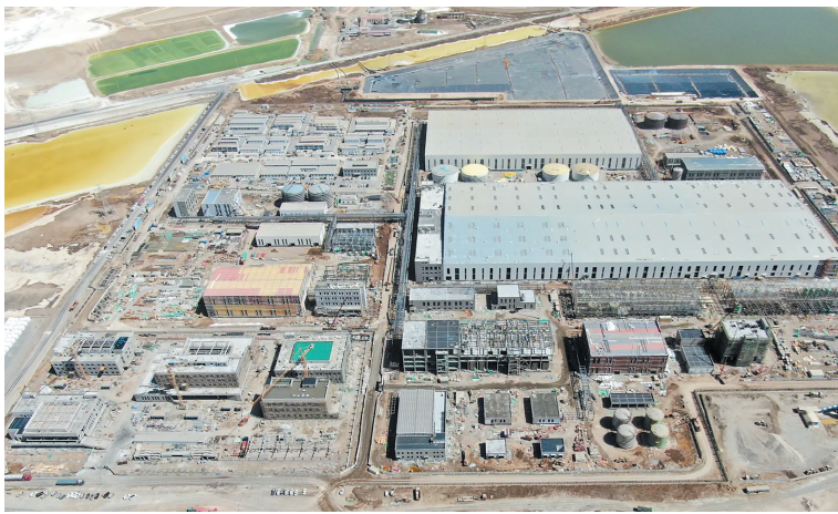
▷4万吨/年基础锂盐一体化项目现场。
