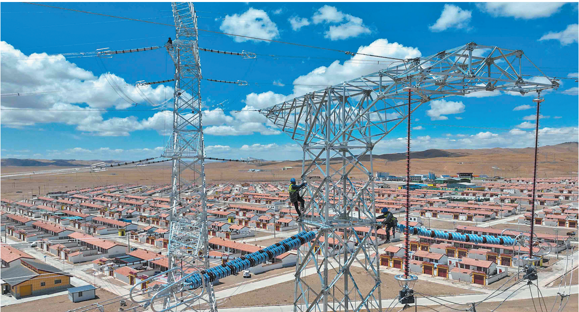
国网青海省电力公司施工人员开展330千伏玉树第二回线路工程消缺工作。张朋 摄
