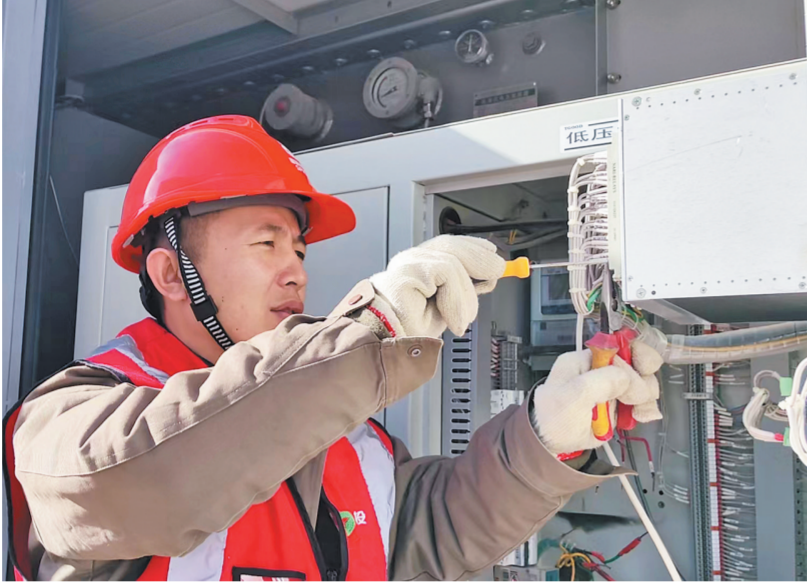
余建昌诊断及处理箱变通讯管理机故障。
