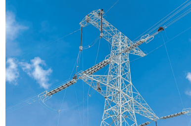
玉树330千伏第二回线路工程铁塔引流线安装。通讯员 马健 摄
