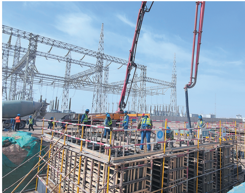
羚羊750千伏输变电工程施工现场，开展羚羊330千伏开关站升压扩建工程750千伏主变压器设备基础混凝土浇筑工作。国家电网青海公司供图
