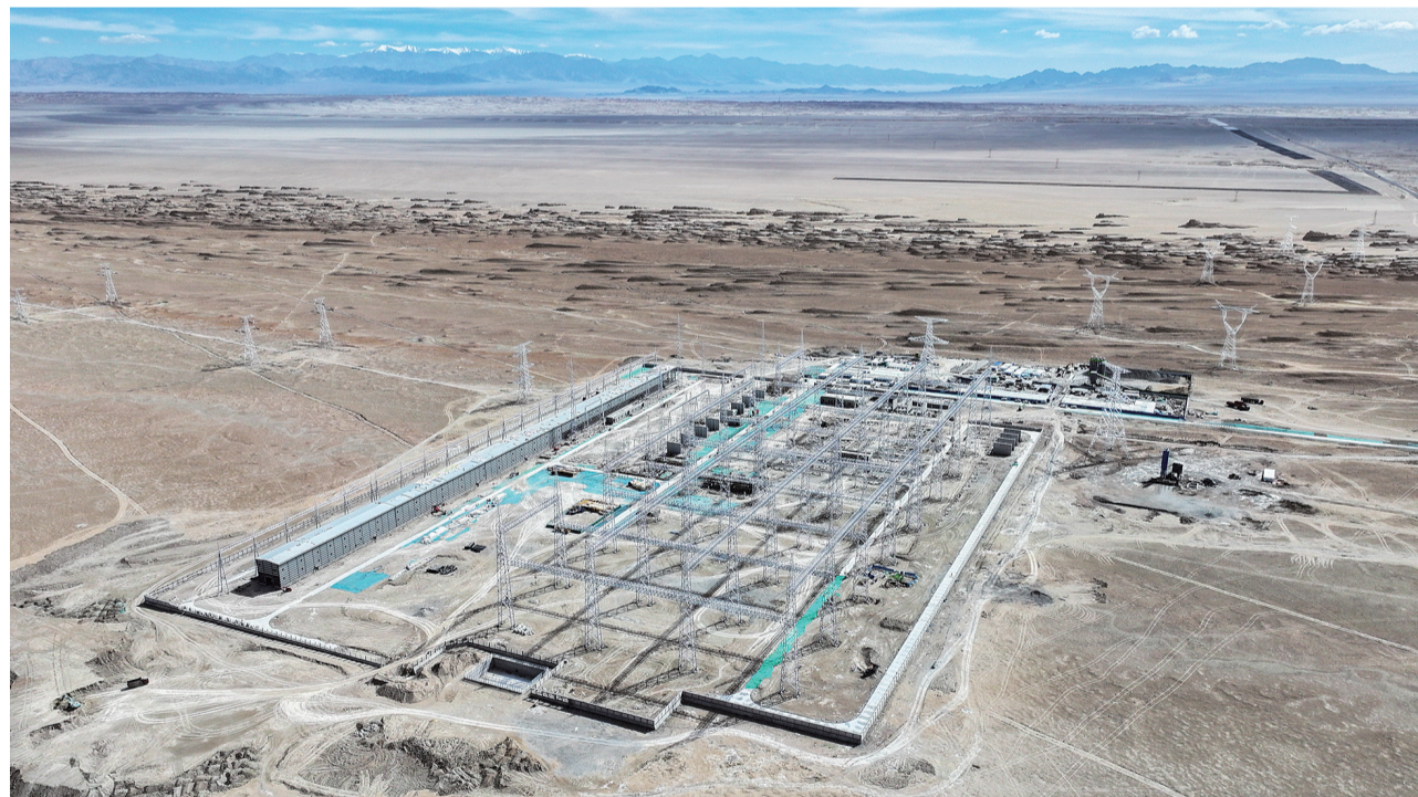
丁字口750千伏输电工程航拍图。
