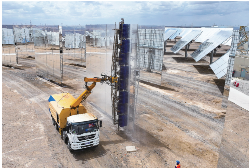
中国绿发鲁能集团格尔木新能源公司海西州多能互补集成优化示范工程基地光热发电场内清洗定日镜。
