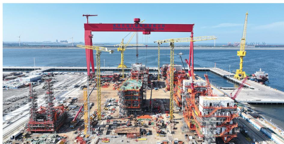
这是6月17日拍摄的海油工程天津智能化制造基地(无人机照片)。位于天津港保税区临港经济区的海油工程天津智能化制造基地是我国首个海洋油气生产装备智能制造基地，设计年产能8.4万吨结构吨，拥有海上油气平台导管架、组块、生活楼陆地建造与海上安装、风电项目陆地建造、海管铺设等能力，已陆续为我国渤海海域多个海上油气平台建造单体、组块项目。
