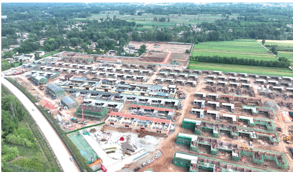
安置项目全景图。
