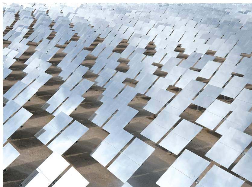
青海中控50MW塔式熔盐储能光热电站镜场。本报记者 李庆玲 摄
