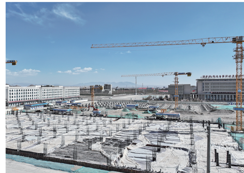
海西州大数据产业园建设现场。
