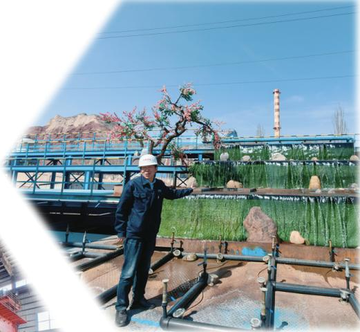
青海天健硅业的工业循环水处理站，工业污水经过深度处理回用，达到近零排放。
