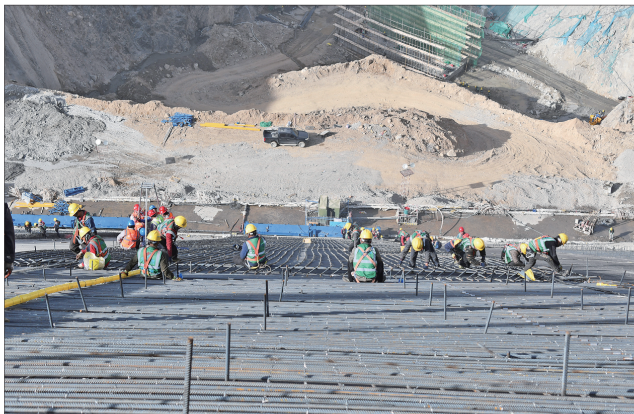
4月7日，由中国水利水电第四工程局有限公司承建的国内首座镶嵌混凝土面板堆石坝面板首仓混凝土开始浇筑，标志着黄河羊曲水电站大坝施工进入决战施工阶段。该工程坝体沉降量较常规混凝土面板堆石坝降低30%以上，可减少狭窄河谷趾板基础开挖量，同时有效降低面板堆石坝沉降变形，为我国300米级高面板堆石坝建设提供了实践经验。
