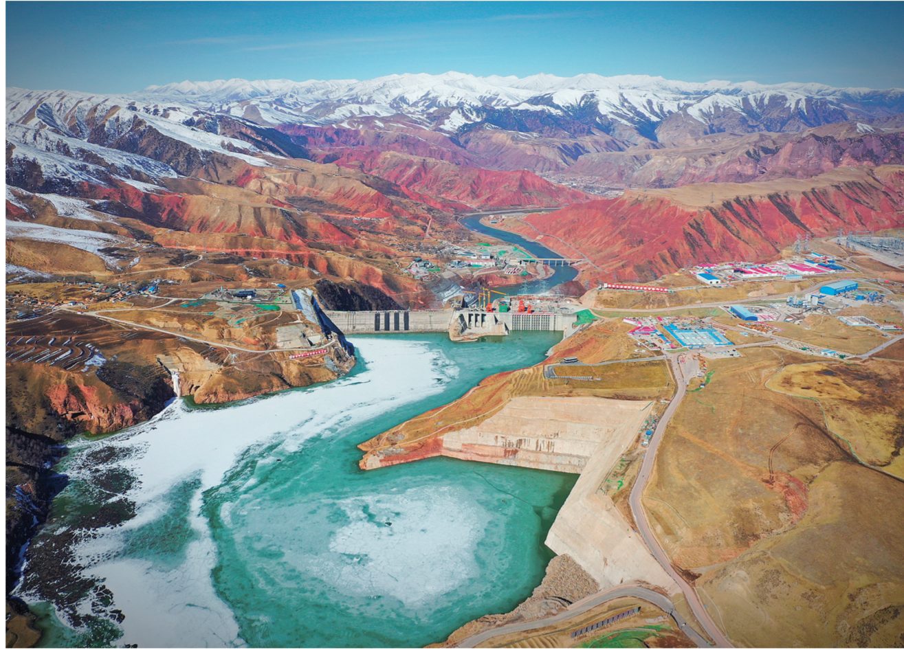
玛尔挡水电站全景。
