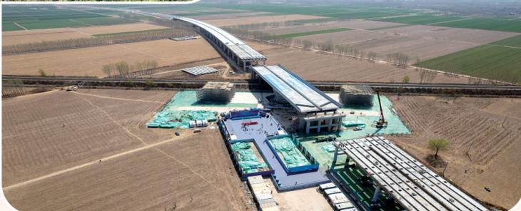
上跨邯黄铁路分离式立交桥完成转体(3月31日摄，无人机照片)。
