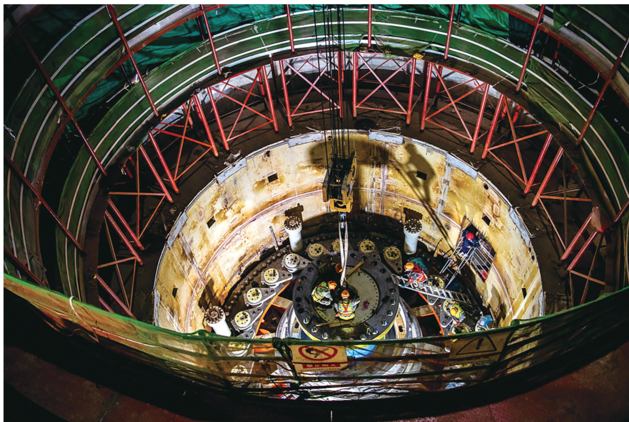
↑3月24日，玛尔挡水电站地下厂房正在进行3号机组中心孔补气装置中法兰吊装。
