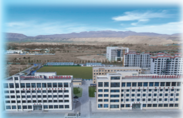
俯瞰海南州创业孵化实训园。企业供图
