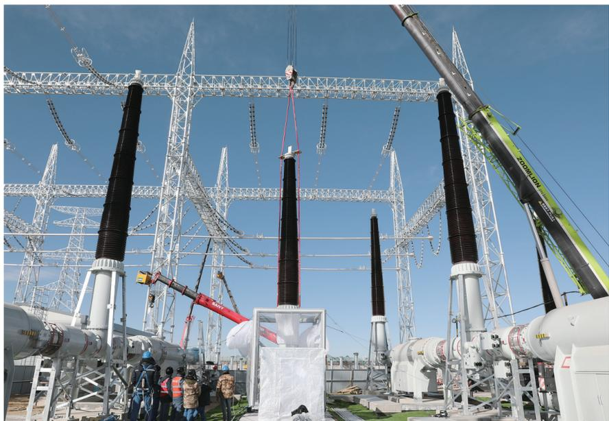
▲施工现场750千伏区域HGIS套管安装工作。
