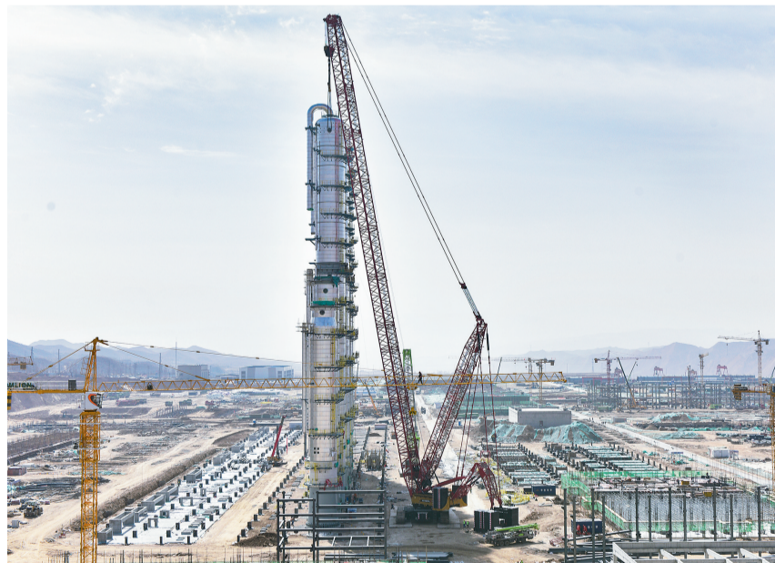
「红狮硅基新材料」项目的现场。本报记者 张鹏 摄
