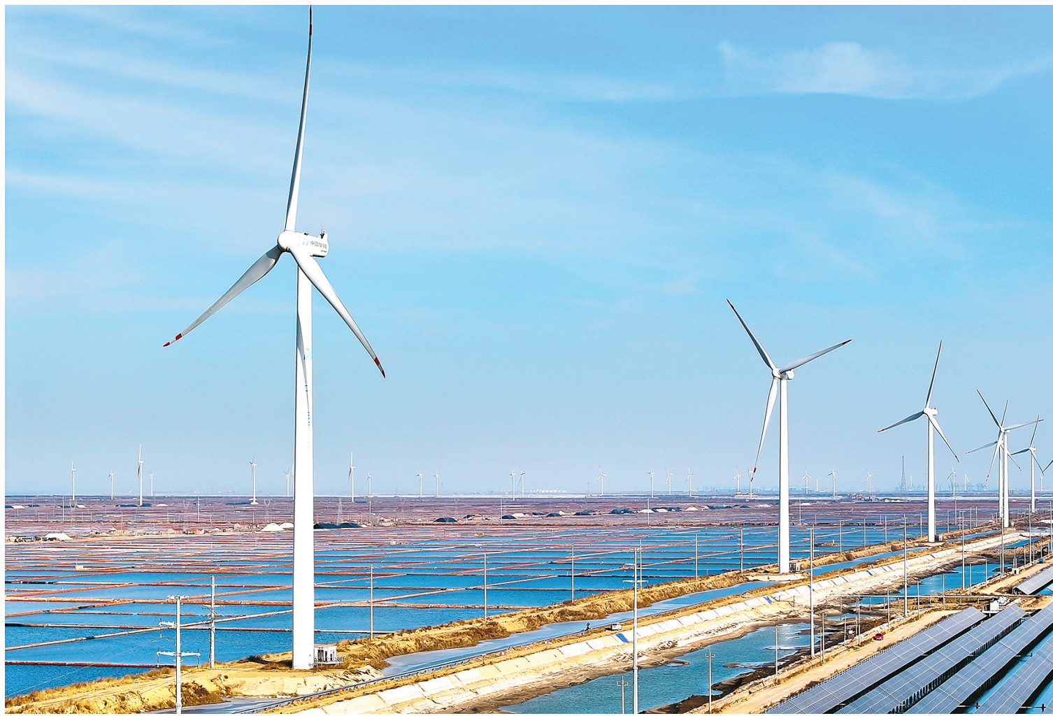
这是山东省寿光市营里镇恒远光伏项目(2024年1月26日摄,无人机照片)。该项目可以实现“光伏发电+新型储能+盐业制卤+水产养殖”等项目融合开发。 新华社记者 郭绪雷 摄
