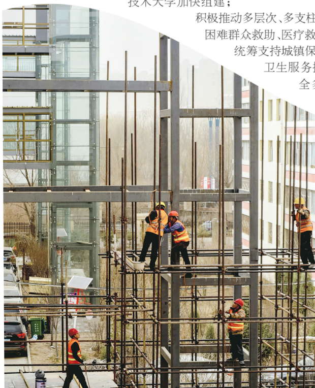
政府补贴老旧小区加装电梯。
