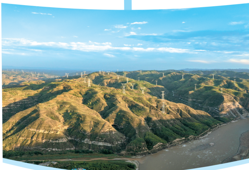
±660千伏银东直流与特高压输电线路跨越黄河。 徐可 摄
