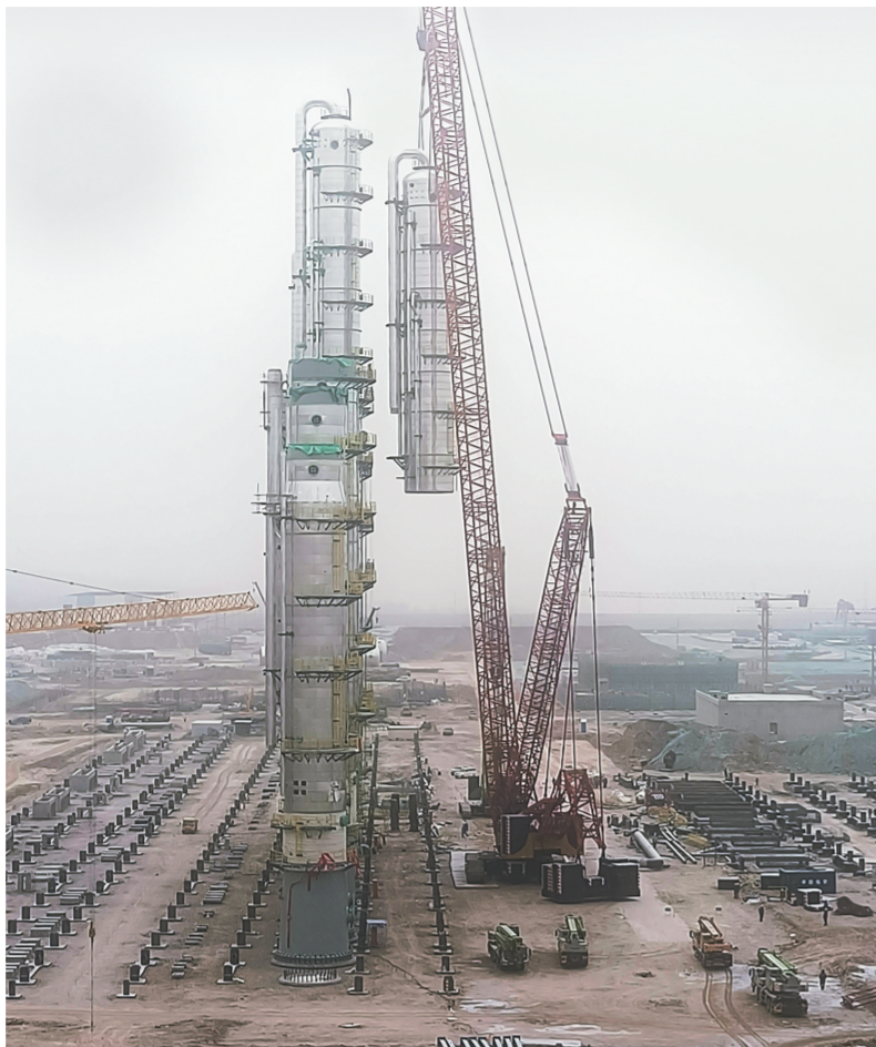
项目施工现场。
