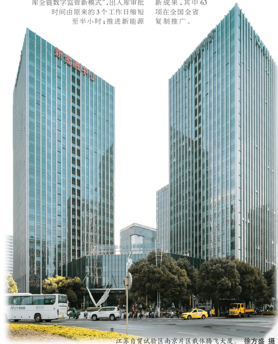
江苏自贸试验区南京片区载体腾飞大厦。徐方盛摄
