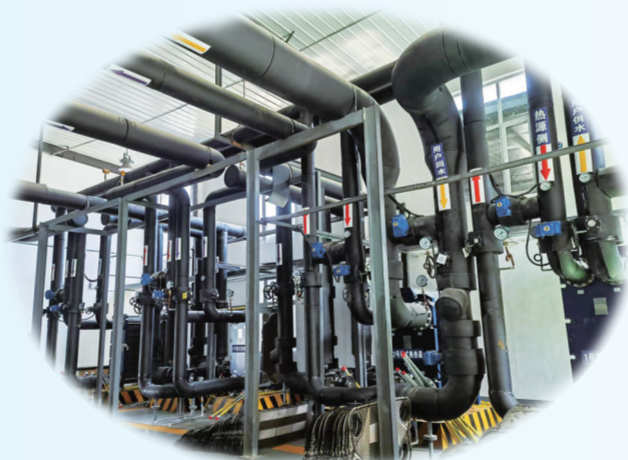
海南州共和县城北新区的地热供暖改造示范项目车间。
