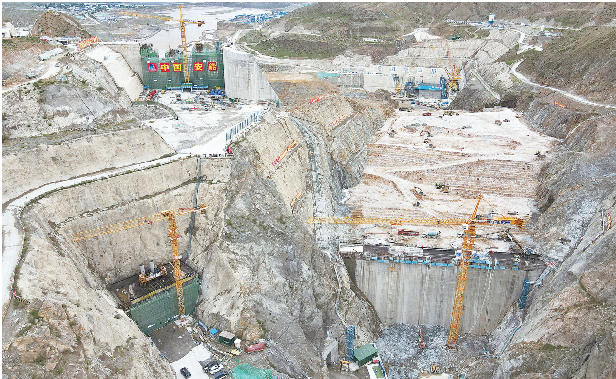
大坝建设现场。
