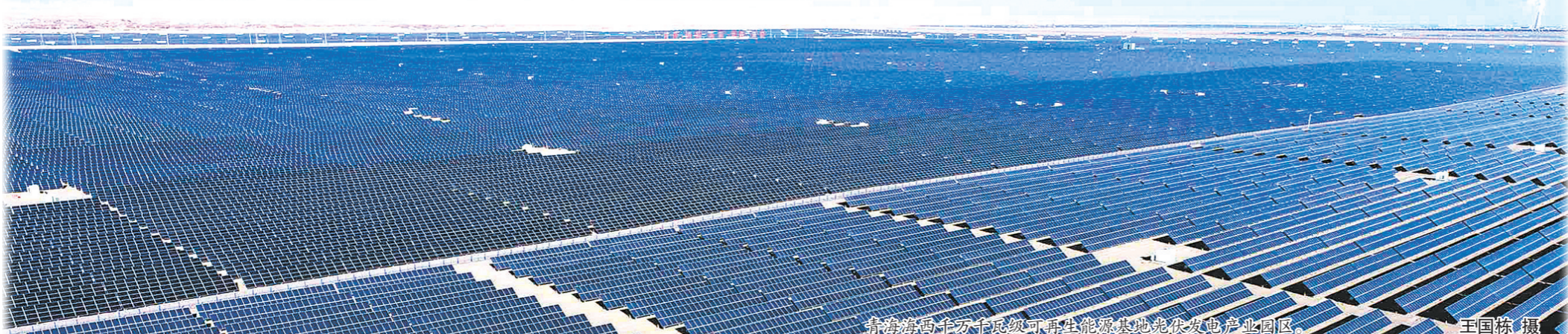
青海海西千万千瓦级可再生能源基地光伏发电产业园区。
