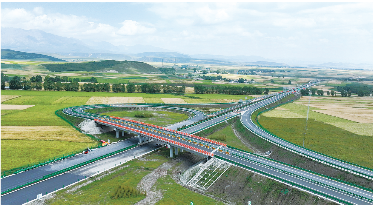
高都口至门源高速公路。
