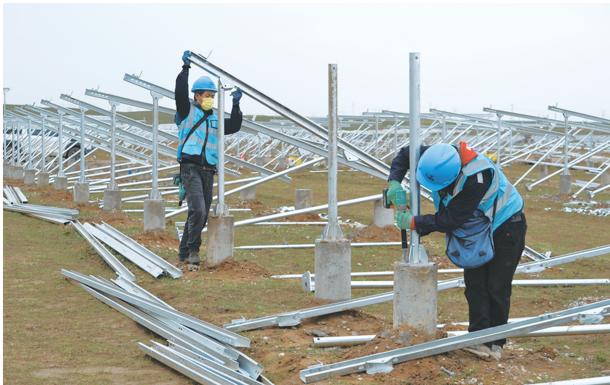
工人们正在安装光伏支架。
