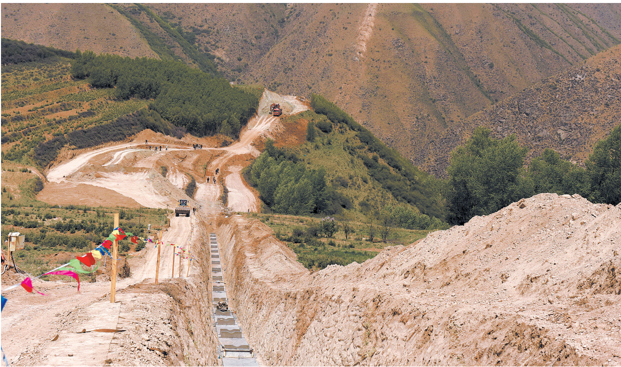
倒虹吸出口段建设现场。
