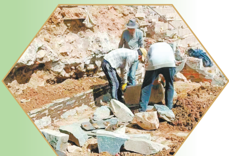
宁巴石匠用传统工艺砌石筑墙。李庆玲 循组 王桂萍 摄
