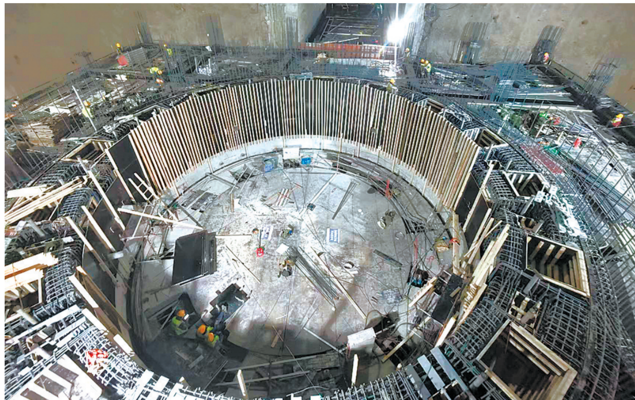
五号水轮发电机组,定子机座施工现场。
