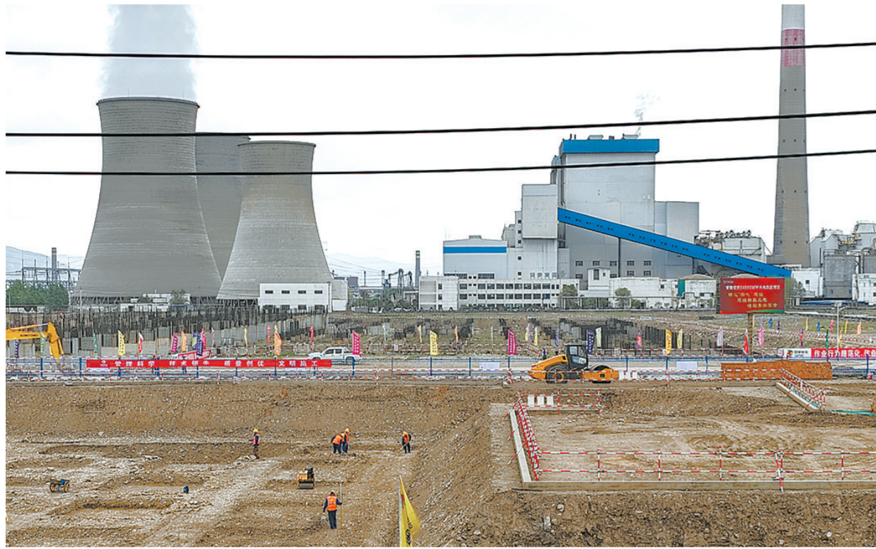
工地现场有序施工。
