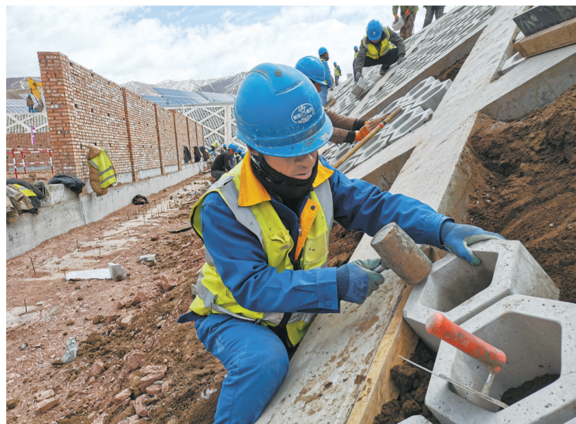
工人进行护坡施工。
