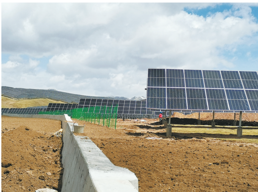
搭建完成的光伏电板。
